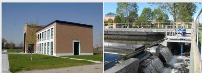
Depuratore Nosedo – Palazzina Servizi Generali e pompe di trasferimento acque depurate alla centrale www.depuratorenosedo.eu
