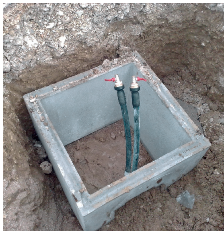
Tutte dotate di sfiati, le sonde verticali sono realizzate con tubazioni in polietilene a U e sono profonde 100 o 120 m, annegate all'interno di un getto di materiale cementizio con additivi per migliorare lo scambio termico (Studio Associato Graziani Sparapani).
