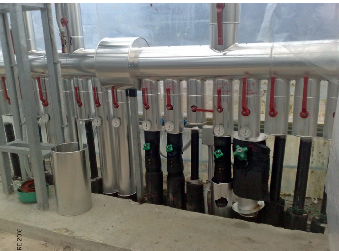
La temperatura dell'acqua nelle sonde varia fra 2\pm 3\text{ }^{\circ}\text{C} e 9\pm 10\text{ }^{\circ}\text{C} , con \Delta T\ 5\text{ }^{\circ}\text{C} : il corretto bilanciamento dell'impianto permette a tutte le sonde di offrire il medesimo contributo indipendentemente dalla loro posizione (Studio Associato Graziani Sparapani).
