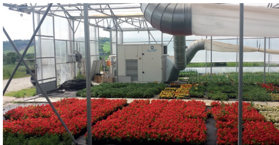
(In alto) Le unità rooftop sono normalmente installate all'aperto, perciò in condizioni meteorologiche e climatiche avverse quali sono quelle che si registrano all'interno delle serre, a causa dell'alta temperatura e dei livelli di umidità (Studio Associato Graziani Sparapani).
