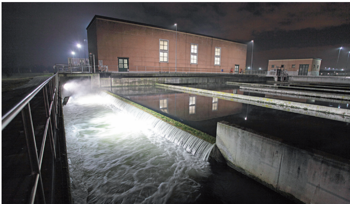
Nel depuratore vengono "rigenerati" ogni anno 150 milioni di metri cubi di acque di scarico provenienti dal bacino scolante centro orientale di Milano, pari al 50% dell'intera città.
