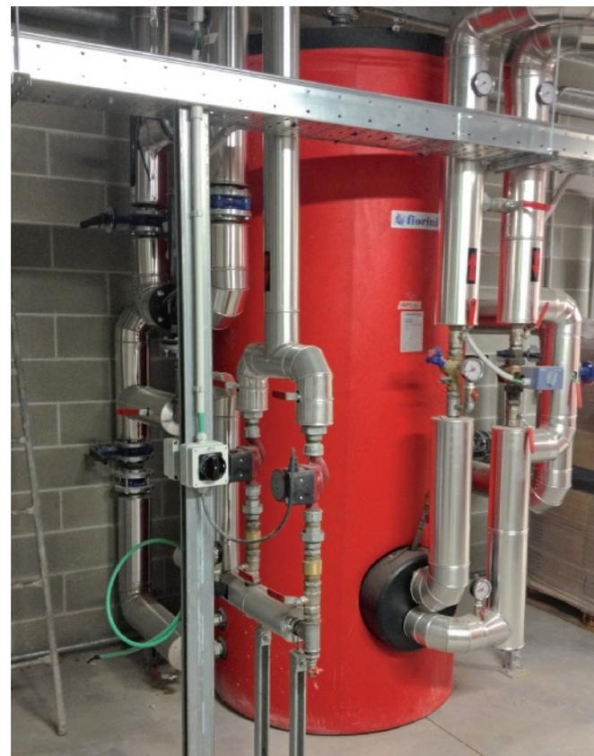
**La fornitura del calore per il riscaldamento invernale avviene tramite la rete di teleriscaldamento urbana, mentre per il raffrescamento estivo è previsto il ricorso indiretto e diretto all'acqua di falda (COPRAT).**
